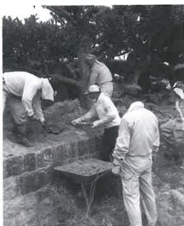
土壁の除去をされているところです。 大変暑い中の屋外での活動でした。
